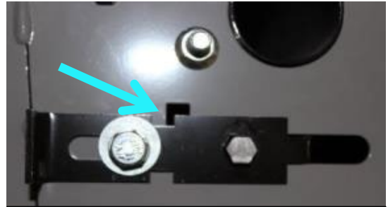
Deslice el soporte amortiguador para alinear los orificios cuadrados. (Ubicación del punto medio)
